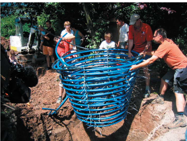
Im vergangenen Sommer versenkte Familie Fritz neun Erdwärmekörbe im Garten (links). Inzwischen ist die Heizung zum zweiten Sofa der Familie geworden
